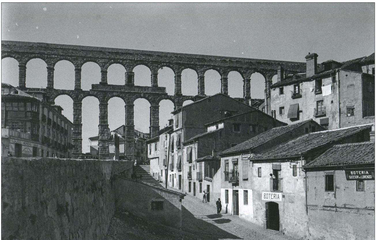
Figura 12. Arco triunfal en las arcadas del Acueducto en el Azoguejo. a) Arriba, izquierda:, desde la desaparecida calle Perocota. b) Arriba, derecha: desde la calle San Juan (Foto: Otto Wunderlich, 1926). c) Abajo: desde la rampa de la antigua calle de Gascos (Foto: Otto Wunderlich, 1926).
