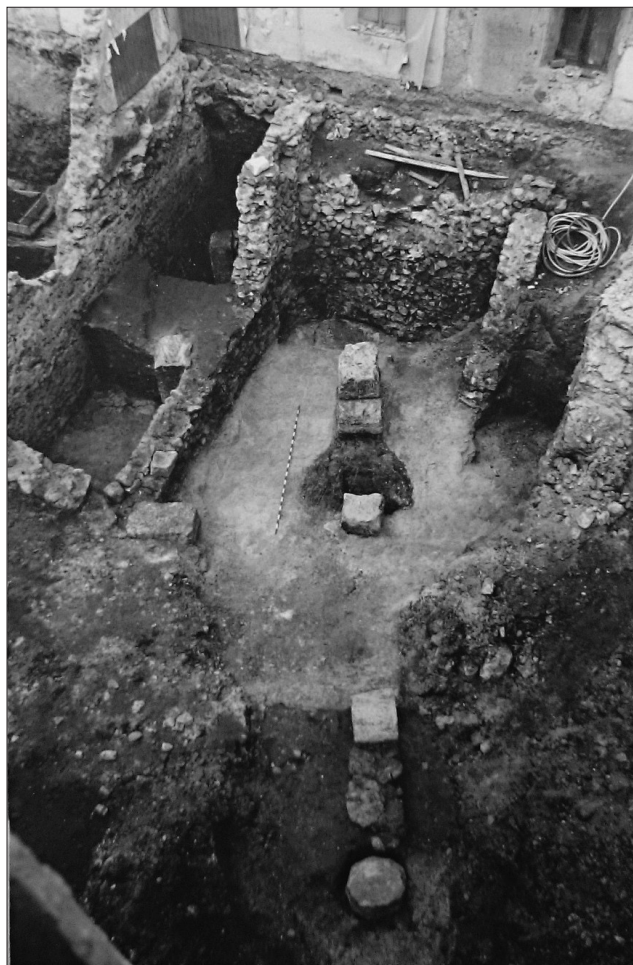
Figura 5. a) Arriba, izquierda: plano de localización de las estructuras del Foro municipal, en el área de la Plaza de Guevara. b) Abajo: substrucciones de edificio del foro municipal (Foto: Servicio Territorial de Cultura de Segovia, Junta de Castilla y León).
